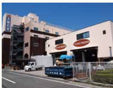
大阪石材工業 本社
